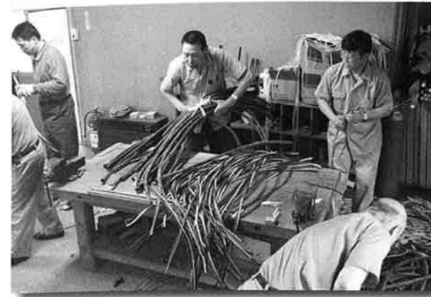
新しい作業も軌道に乗りました 銅線被覆外し作業(6月)
