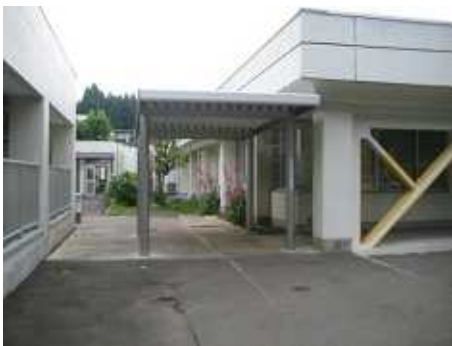
新設したカーポート
