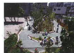
第一期工事 サイクルロード完成 / The 1st phase of construction - Completion of a cycling road
