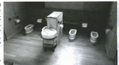
座る向きに合わせトイレトーパーを設置
