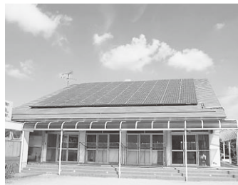
別棟のホール屋根にソーラーパネル
